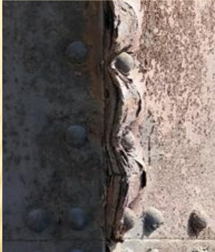
Figure 35 : Corrosion foisonnante entraînant une importante traction sous tête des rivets
