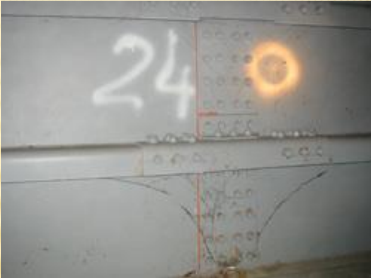
Figure 61 : Jeu sur assemblage boulonné mis en évidence par la rupture du feuil de peinture et apparition de la couche de minium de plomb
