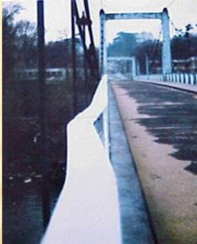
Figure 74 : Flambement de membrure supérieure de la poutre de rigidité hors du plan
