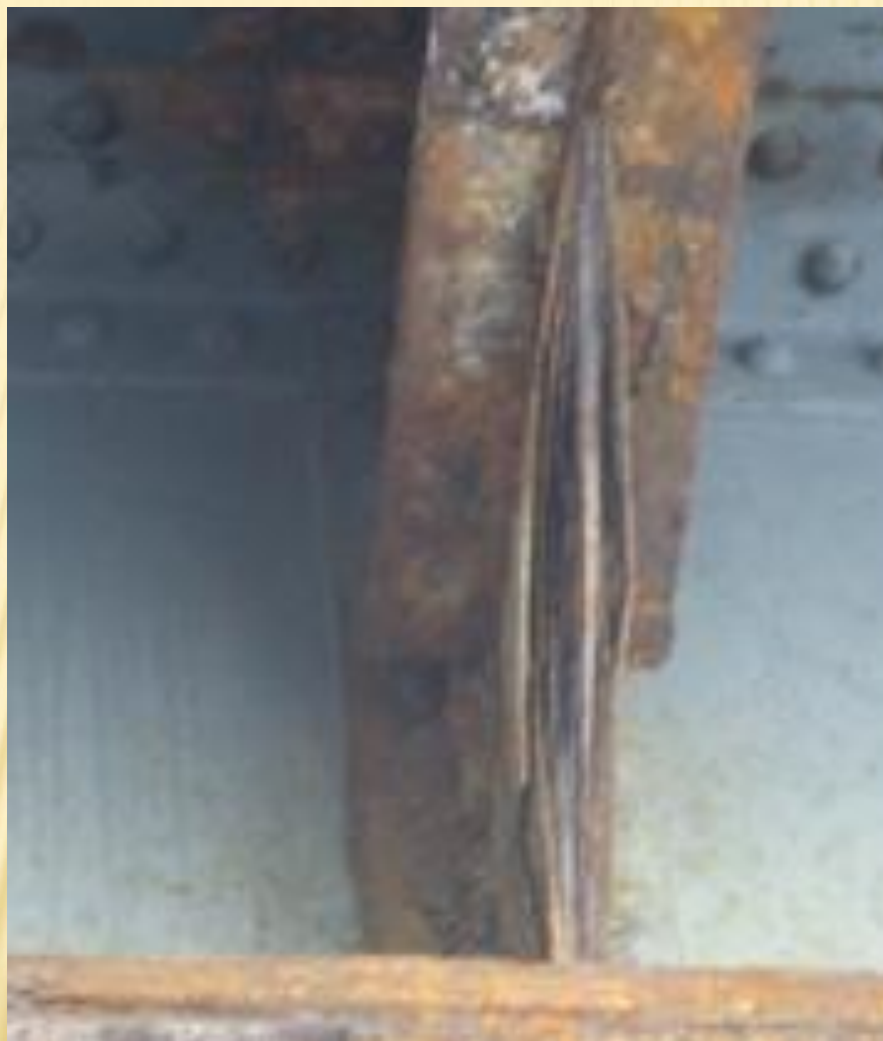
Figure 33 : Corrosion feuilletante d'un gousset sur un ouvrage des années 1960.
