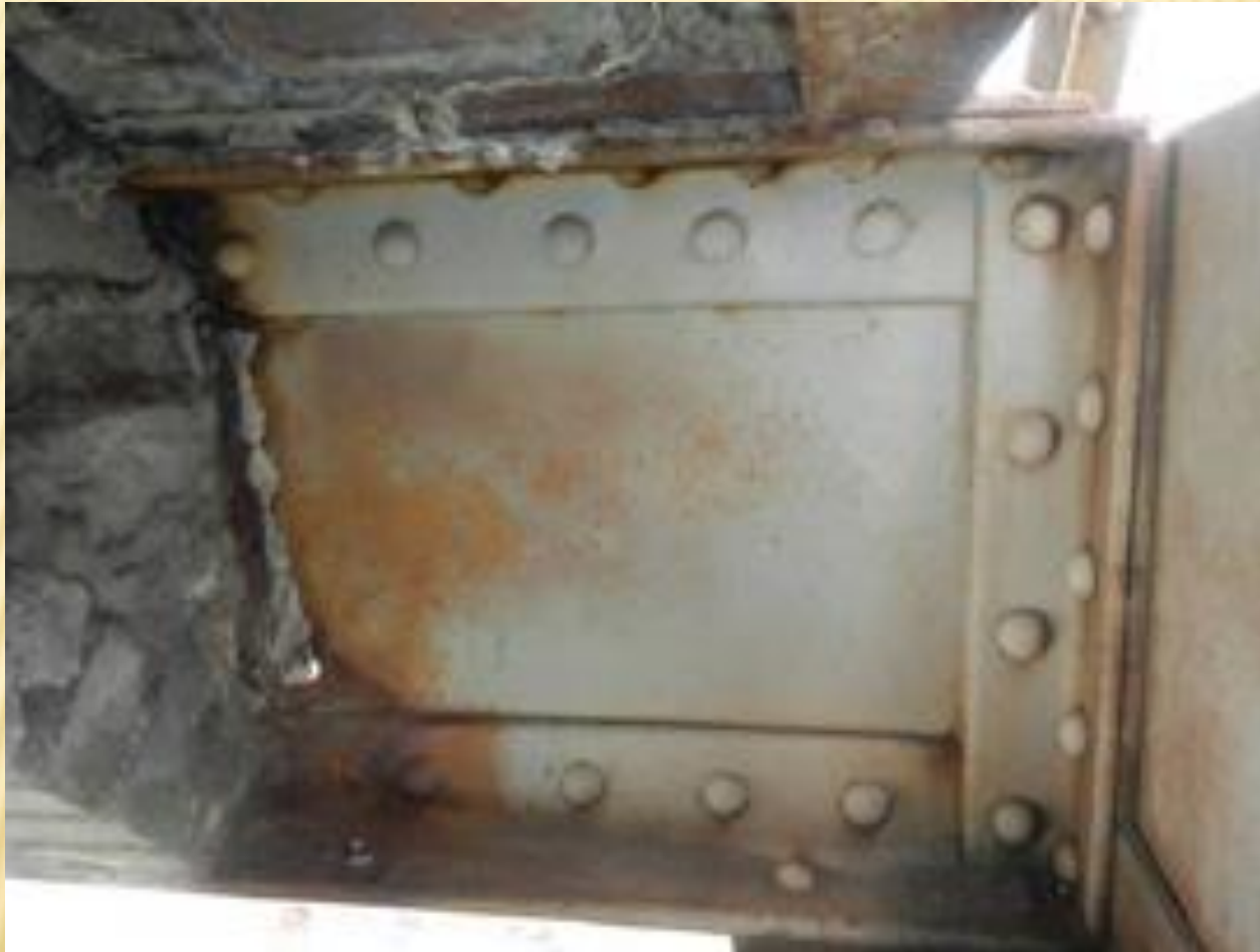
Figure 43 : Corrosion de pièce noyée dans la maçonnerie. Perforation de l'âme, corrosion des cornières de membrures au contact de la maçonnerie
