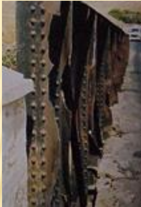
Figure 53 : Ruptures sur acier fragile par chocs de véhicules – acier des années 1925 environ.
