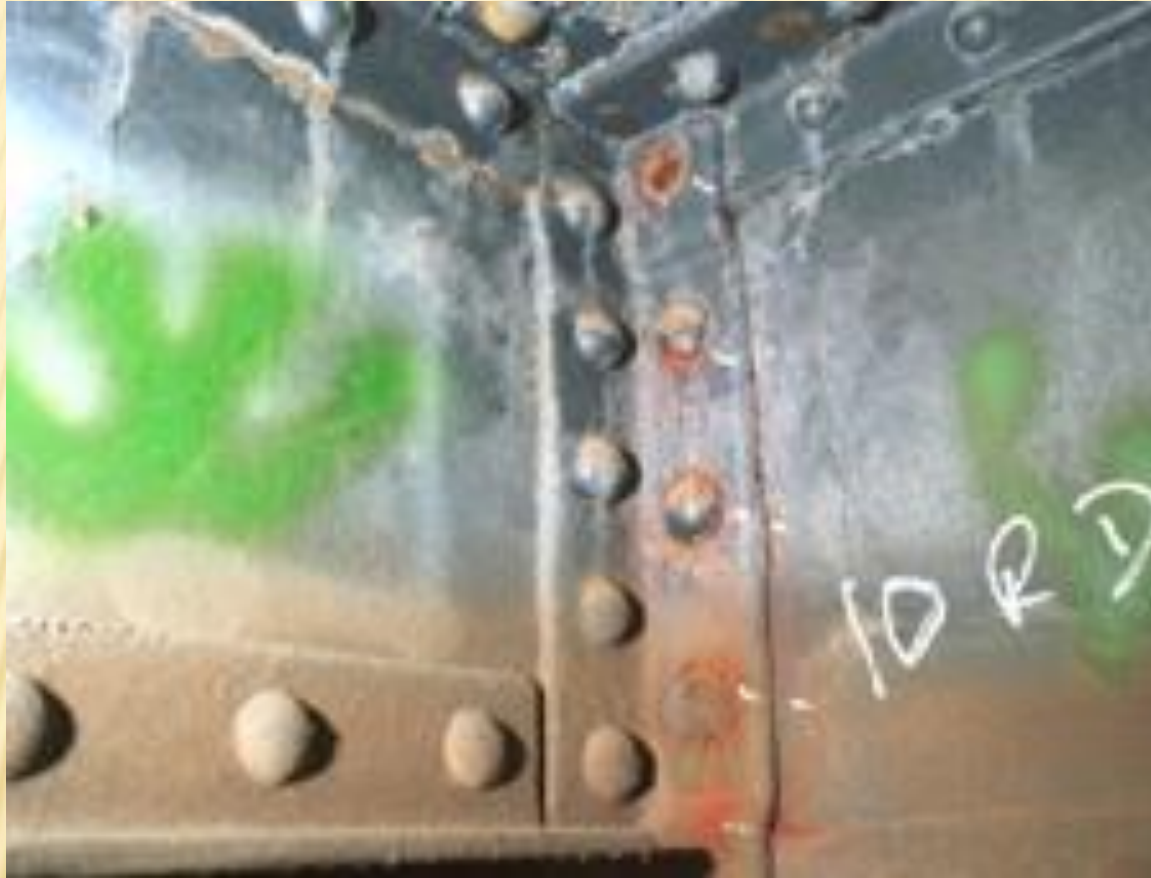
Figure 62 : Différents stades de déconsolidation d'un assemblage rivé
