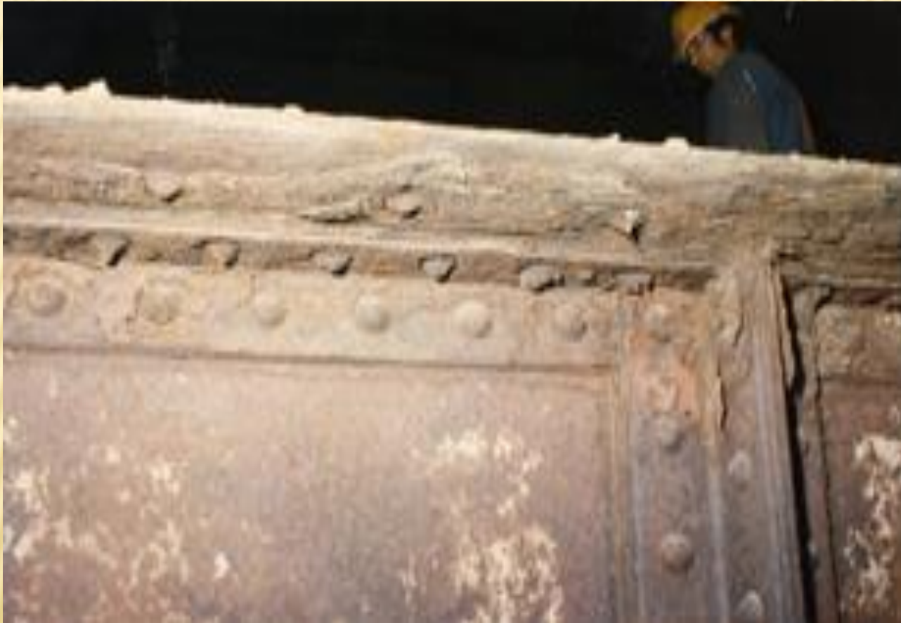
Figure 40 : Dégradation des têtes de rivet par corrosion
