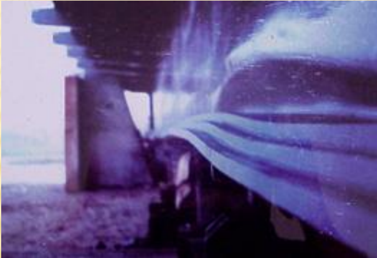
Figure 72 : Voilement d'âme en cours de lancement.
