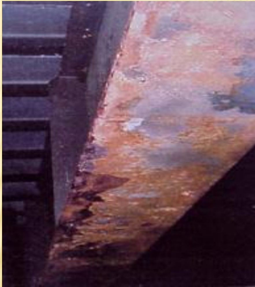
Figure 31 : Enrouillement, et début de corrosion sur zone condensante en sous-face d'une membrure inférieure de pièce de pont
