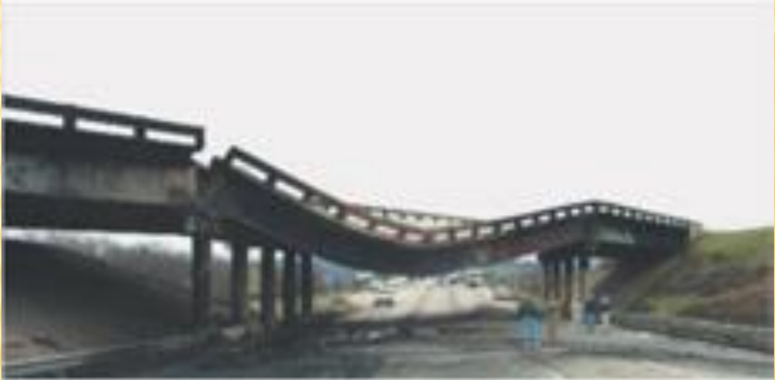
Figure 68 : Pont routier en Alabama USA – 5 janvier 2002 – incendie d'une citerne d'hydrocarbures.
