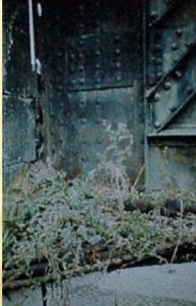
Figure 29 : Piège à poussière, maintien de l'humidité, végétation, foyer de corrosion
