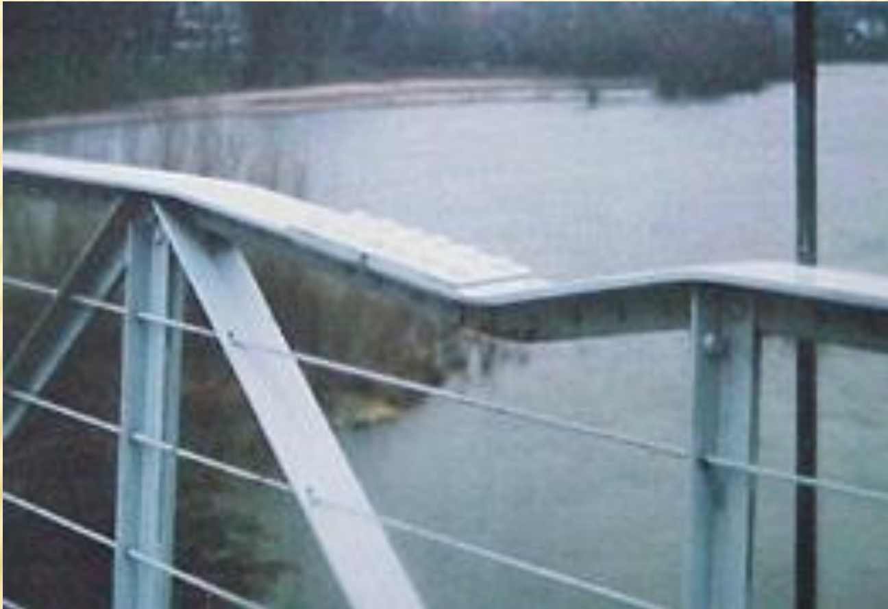
Figure 73 : Flambement de membrure supérieure de la poutre de rigidité dans le plan
