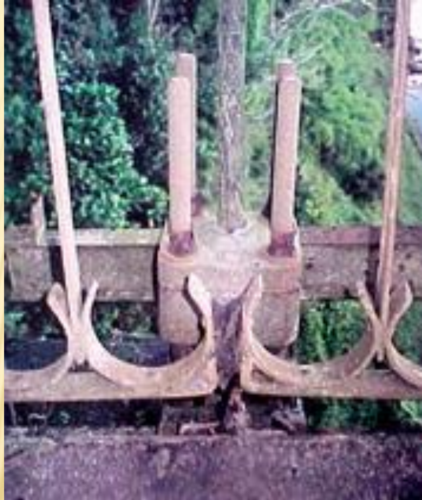
Figure 36 : Corrosion d'écrous
