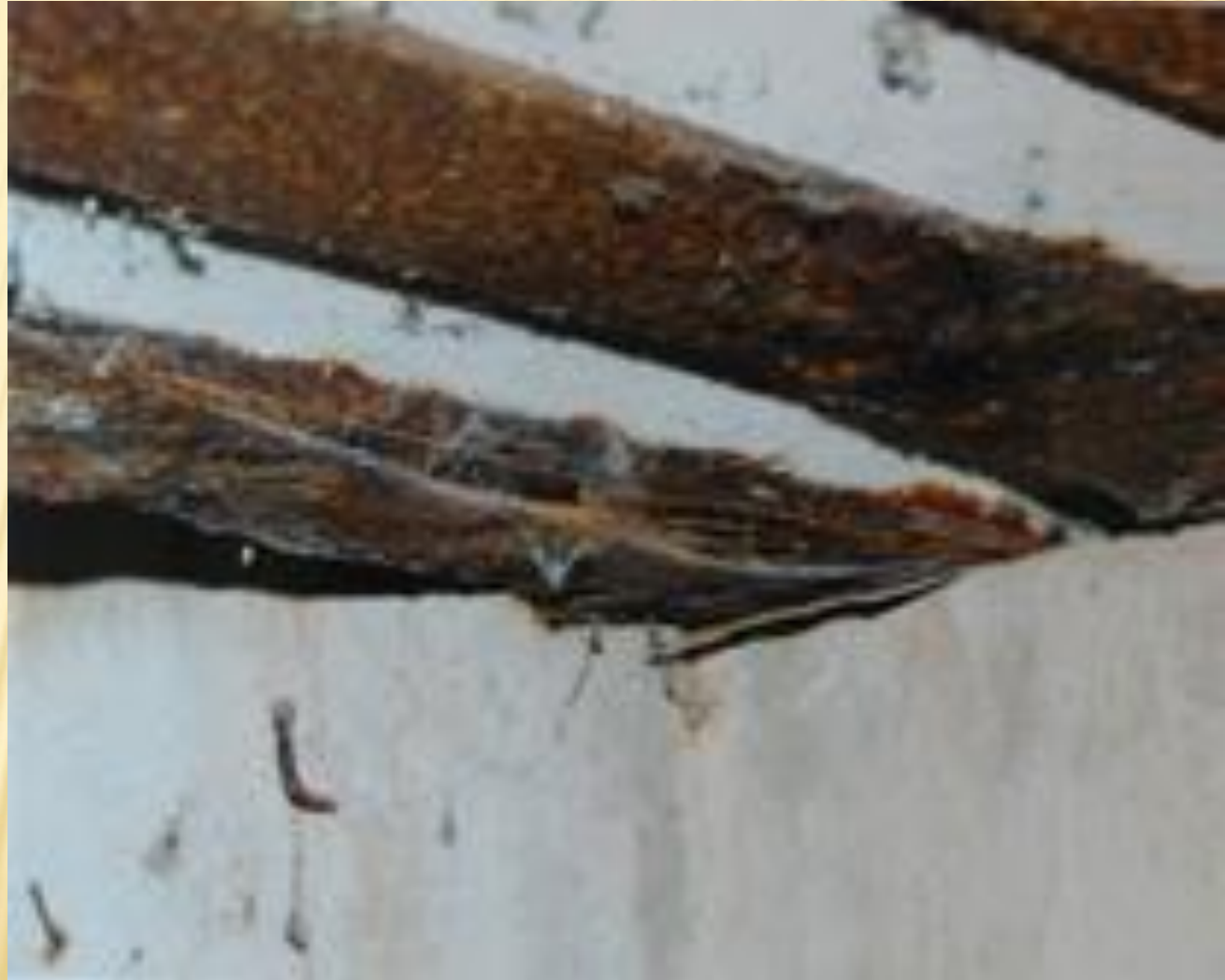
Figure 32 : Corrosion feuilletante d'une membrure inférieure d'une poutre d'un pont à poutrelles enrobé
