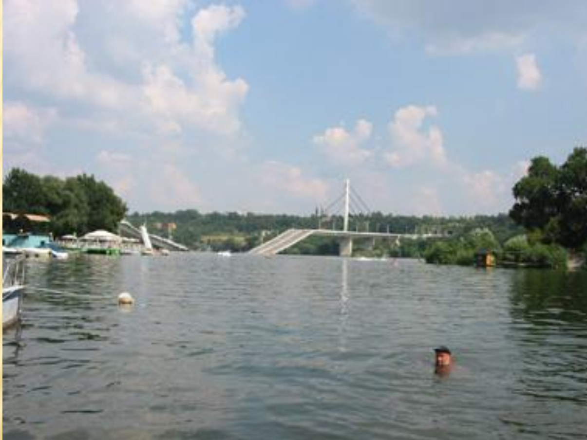
Figure 76 : Effondrement par fait de guerre d'un pont à haubans.
