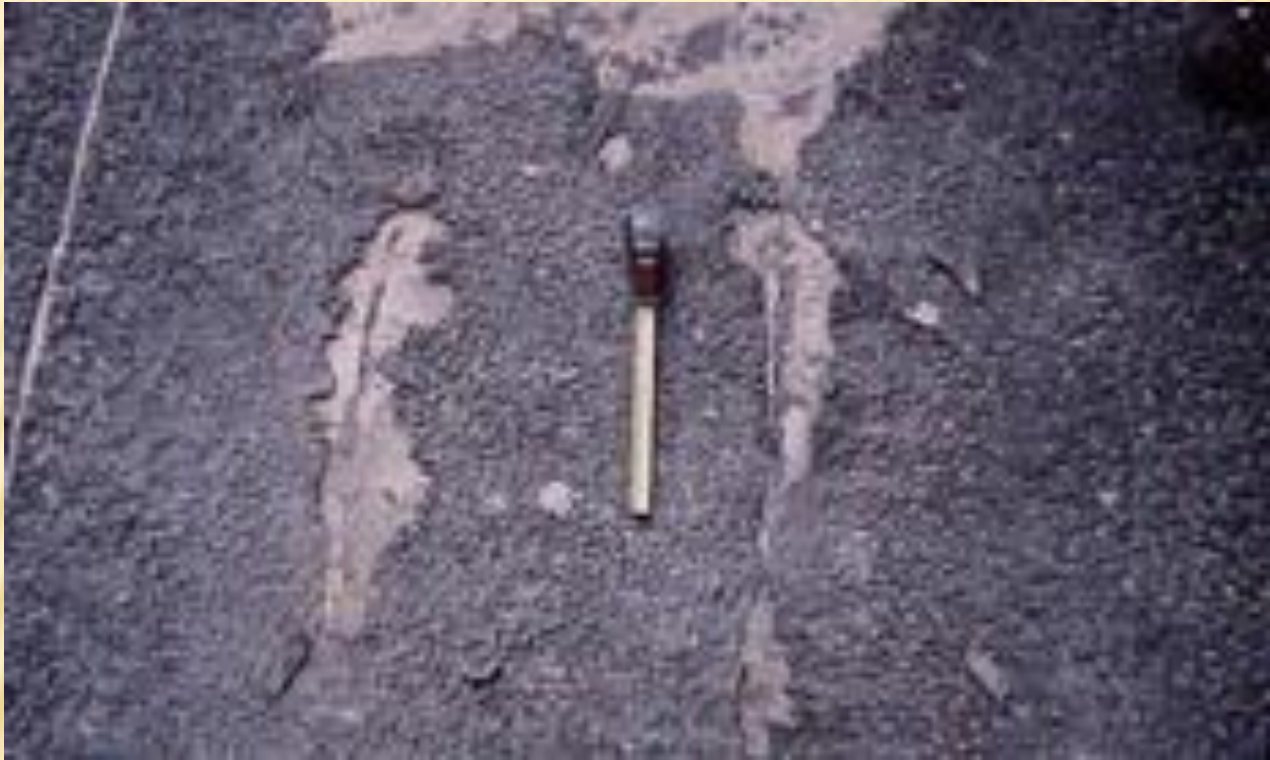
Figure 57 : Fissuration par fatigue de tôle de platelage sous l'effet de la circulation – ici platelage de 10 mm sur autoponts.
