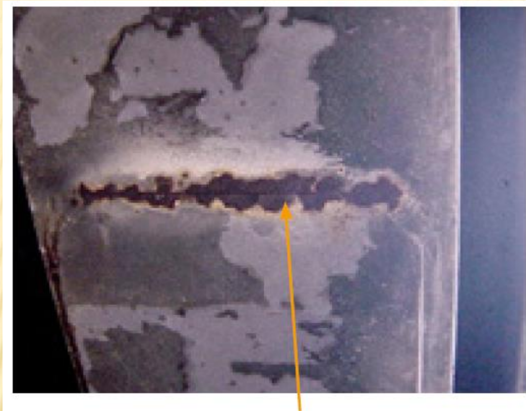
Figure 59 : Fissure frontale d'une semelle additionnelle de membrure inférieure de poutre
